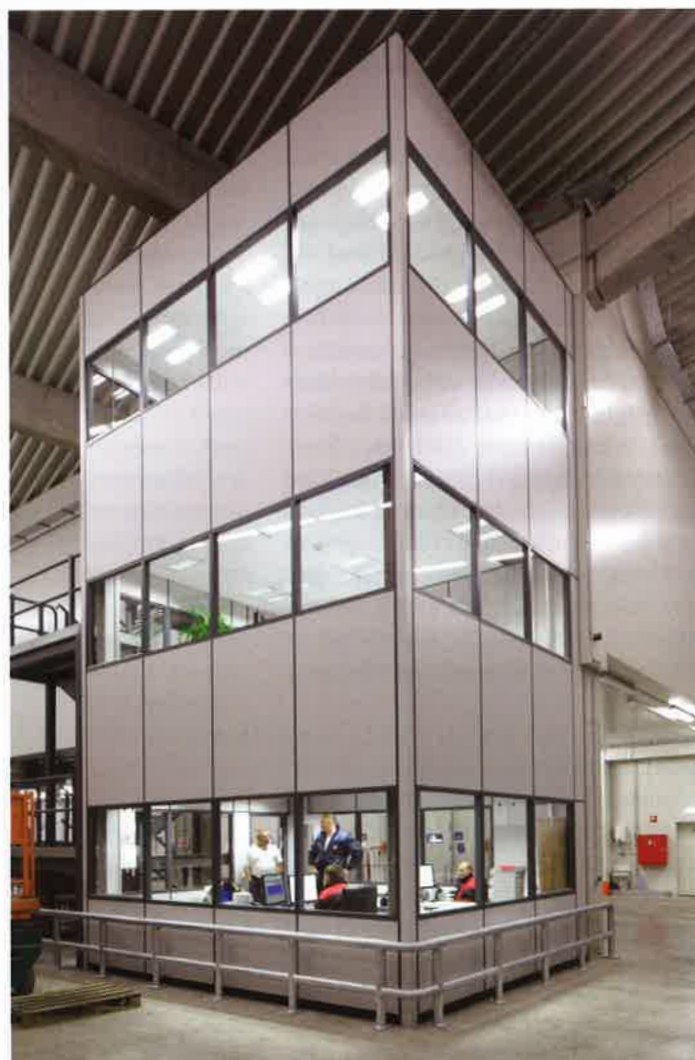
Die Kommandozentrale für den TK-Bereich: Im Tiefkühlagerbüro sitzen Schichtleiter, Tiefkühlleitung und TK-Disposition.
